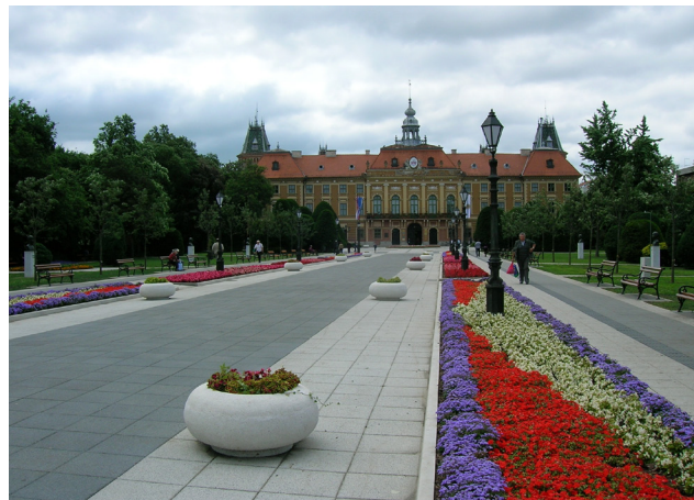
Slika 3. Zgrada somborske Županije. Sombor je 1786. godine postao sedište županije Bač-Bodrog. Prva faza gradnje ove zgrade završena je 1809. godine, a druga 1882. godine. Danas je u njoj smeštena administracija grada i okruga
